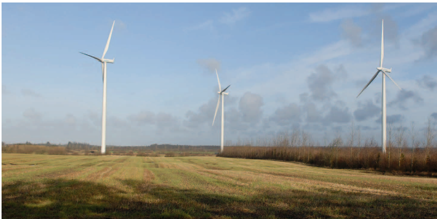
Foto 1. De næststørste vindmøller i Ringkøbing-Skjern kommune er tre 127 m høje vindmøller ved Lyngmose med rotordiameter 93 m og navhøjde 80 m. Der udføres støjmålinger på møllerne, for at verificere støjen fra store serieproducerede møller.
